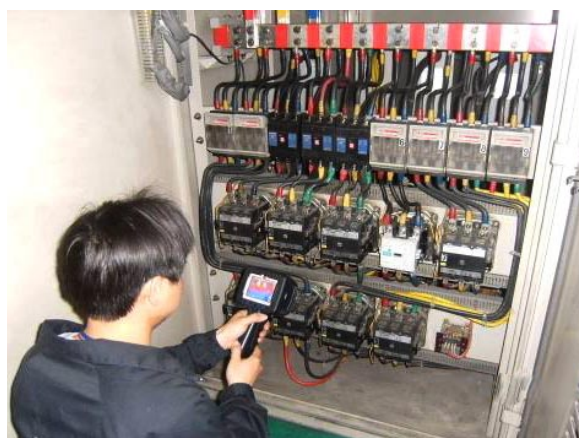
电气安全检查
